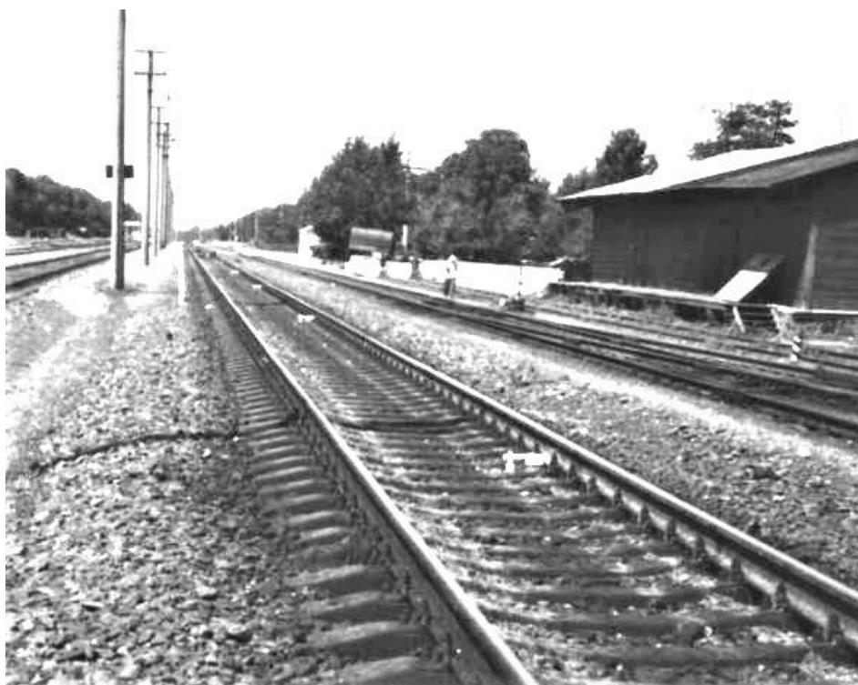
Рисунок 2.11 – Участок пути с оборудованными через 20 метров створами
