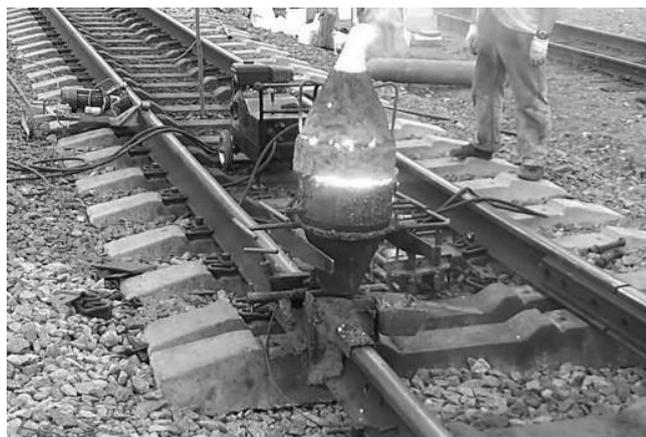
Рисунок 4.8 – Оборудование для термитной сварки рельсов
