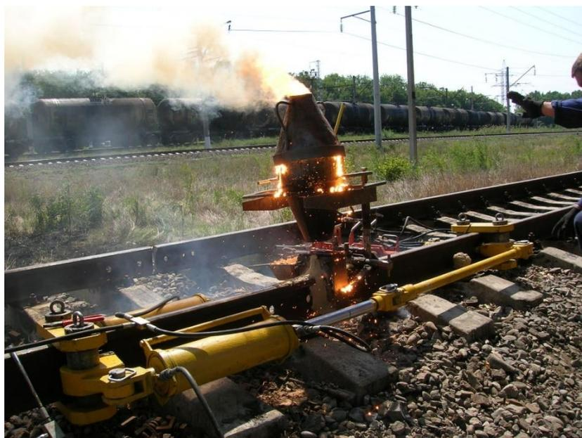
Рисунок 4.6 – Восстановление целостности плети при температуре рельсов на  $20^{\circ}\text{C}$  ниже температуры их закрепления [172]
