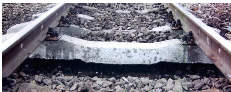
Рисунок 2.27 – Железобетонная шпала по пат. РФ №2433218
