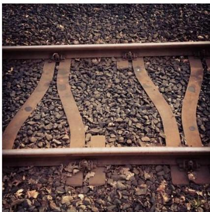
Рисунок 2.20 – Металлические шпалы Y-типа
