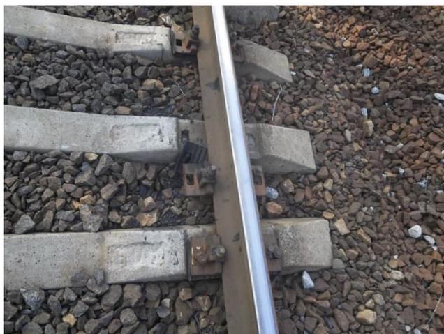
Рисунок 3.6 – Перекос шпал с разрушением элементов креплений
