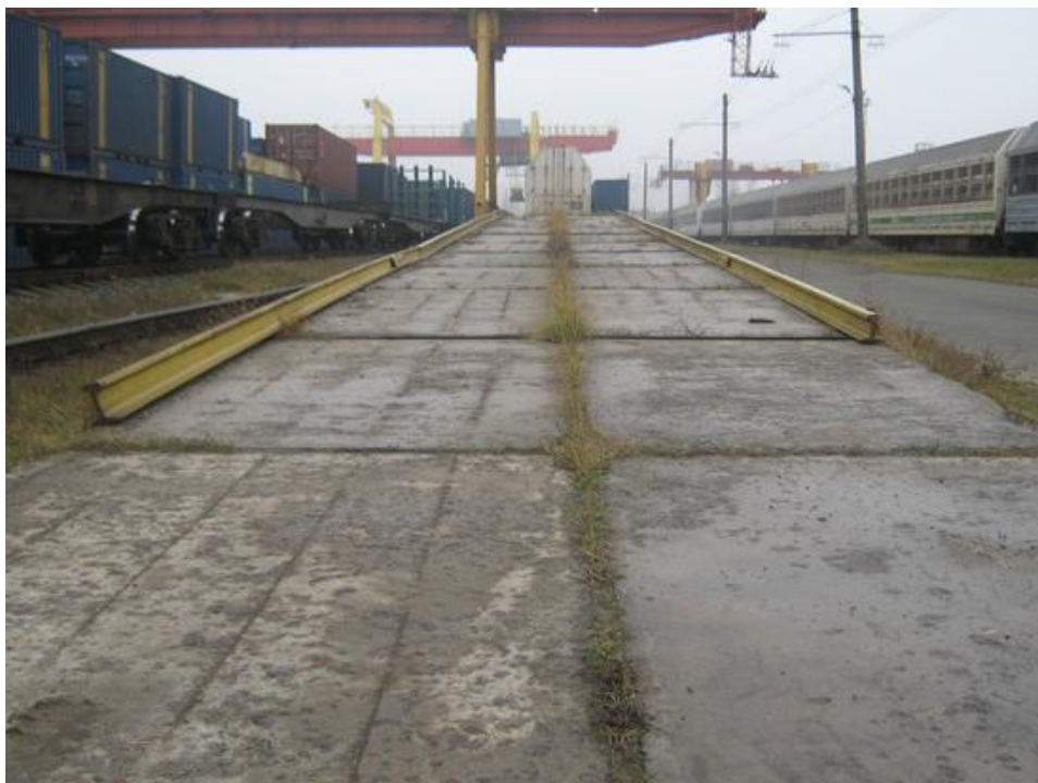
Рис. 3. Рампа для заезда на платформу
