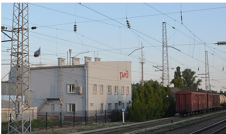
Рис. 15. Пост электрической централизации (ЭЦ), ст. Заречная СКЖД
